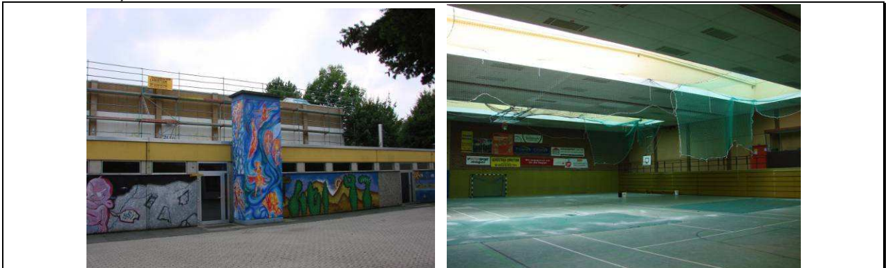
Turnhalle Gymnasium Berliner Str.
