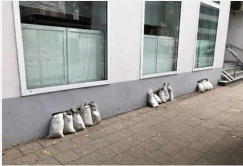
Beispiel: Temporäre Sicherung von Kellerfenstern (Foto: K.PLAN)
