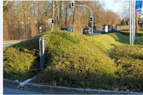
Beispiel: Damm und Schleusentor entlang eines Niederschlags-Hauptfließweges (Soest, Foto: K.PLAN)
