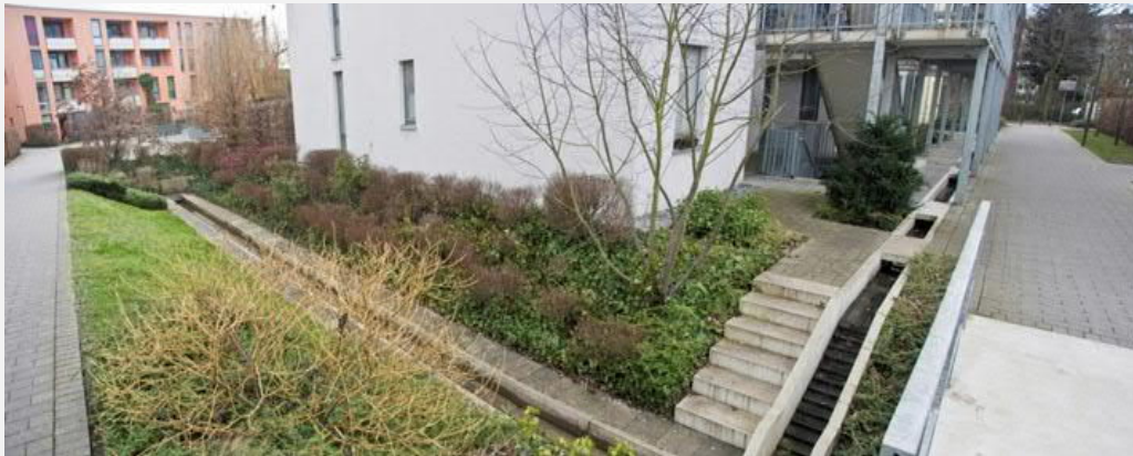
Beispiel: Wasserspielplatz mit Zwischenspeicherung (Neuss, Foto: K.PLAN)
