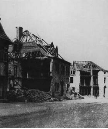
Zerstörtes Postamt an der Haupt- straße/Wilhelmsplatz
